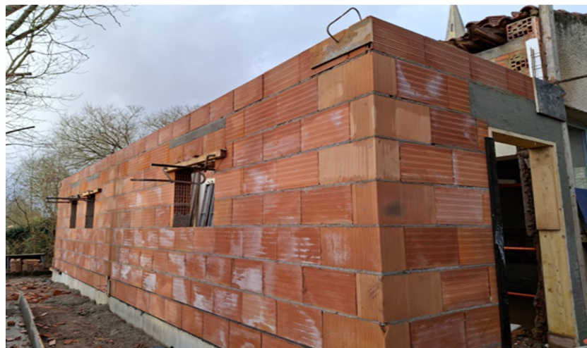
RECONSTRUCTION DE L'ESPACE BAR / CUISINE / SANITAIRE
